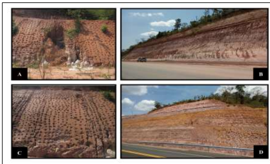
Figura 5 – Mosaico dos taludes de alguns trechos do rodoanel
